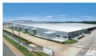
Nhà Máy LIXIL
