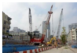
Tuyến Metro Số 1
