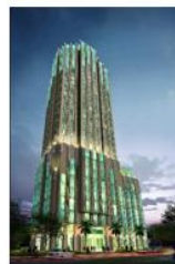
Vietcombank Tower 206m/676 ft Hà Chí Minh, 2014 Nhà thầu chính: COFICO Nhà thầu M&E: REE
