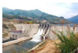
Thủy Điện Bắc Hà
