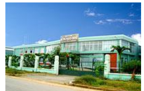
Nhà Máy Bông Bạch Tuyết
