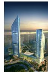
VietinBank Tower 363m/1.191 ft Hà Nội, đang xây dựng Nhà thầu chính: Kumho E&C Nhà thầu M&E: David Stillman Associates Quản lý dự án: Turner Construction
