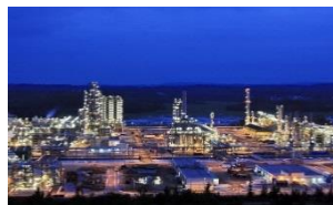
Nhà máy lọc dầu Dung Quất
