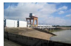
Thủy Điện Trị An
