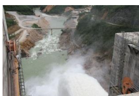
Thủy Điện ĐakR'ih
