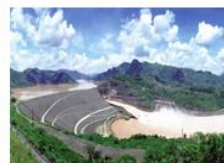
Nhà Máy Thủy điện Hòa Bình - 1.920 MW
